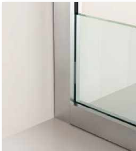
4 Väliseinän kiinnittäminen seinään
